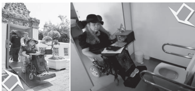
รูปที่ 6 แสดงอุปสรรคในการเข้าใช้พื้นที่ภายในวัดพระเชตุพนวิมลมังคลาราม บนซ้าย แสดงทางลาดของคนพิการใช้รถเข็นมีความลาดชันเกินไป 1:12 บนขวา แสดงห้องน้ำคนพิการของทางวัดที่มีขนาดเล็กเกินไปไม่สามารถกลับรถเข็นได้ ที่มา: ผู้วิจัย (2562)
