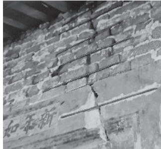
รูปที่ 34 เหล็กเส้นใส่บริเวณรอยแยกของอาคาร ที่มา: ผู้วิจัย (2562)
