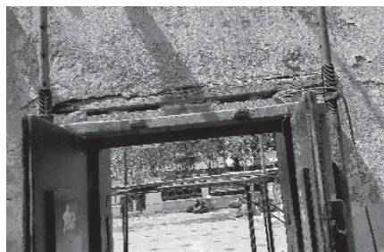
รูปที่ 24 โครงสร้างชั่วคราวเพื่อรับโครงสร้างซุ้มประตู ที่มา: ผู้วิจัย (2562)
