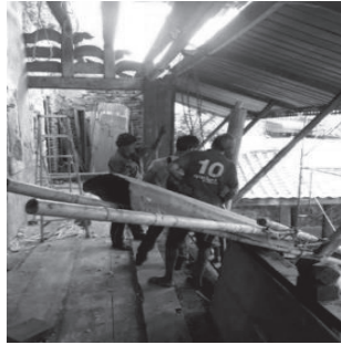
รูปที่ 32 ติดตั้งชักรอกโซ่คานพื้นชั้นสอง ที่มา: ผู้วิจัย (2562)
