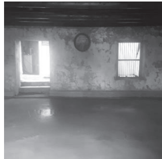
รูปที่ 38 พื้นชั้น 1 เมื่อเทคอนกรีตเสร็จ ที่มา: ผู้วิจัย (2562)
