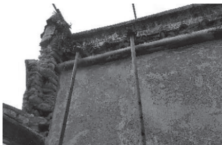
รูปที่ 24 โครงสร้างชั่วคราวเพื่อรับโครงสร้างซุ้มประตู ที่มา: ผู้วิจัย (2562)
