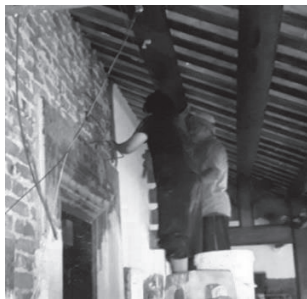
รูปที่ 34 เหล็กเส้นใส่บริเวณรอยแยกของอาคาร ที่มา: ผู้วิจัย (2562)
