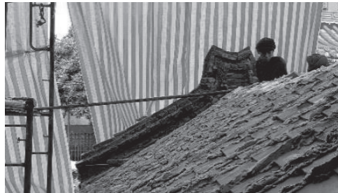
รูปที่ 12 ฉาบปูนแทนกระเบื้องตัวหงาย ที่มา: ผู้วิจัย (2561)
