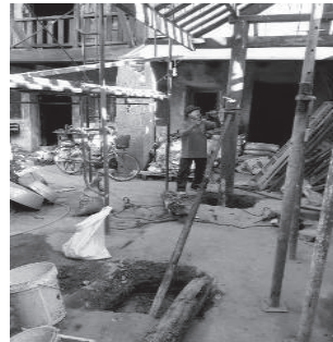
รูปที่ 18 เหล็กค้ำโครงสร้างชั่วคราว รับโครงสร้างไม้เดิม ที่มา: ผู้วิจัย (2561)
