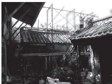
รูปที่ 15 เตรียมการรื้อหลังคาอาคารฝั่งซ้าย ที่มา: ผู้วิจัย (2561)
