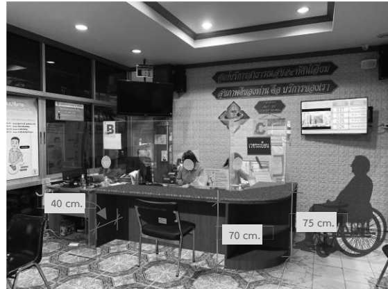
รูปที่ 7 เคาน์เตอร์เวชเชเรียบีและเคาน์เตอร์พยาบาลสภาพปัจจุบันและแนวทางการปรับปรุง ที่มา: ผู้วิจัย (2566)
