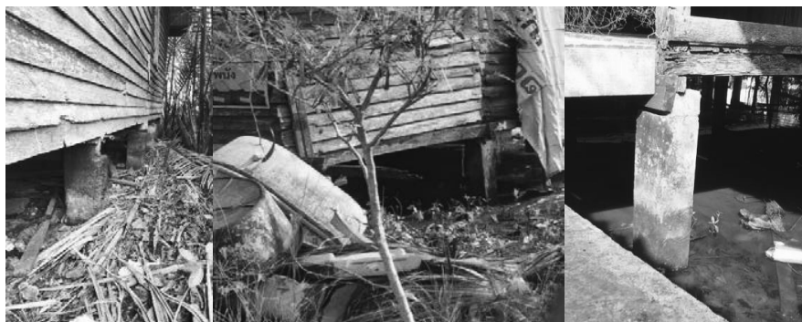
รูปที่ 7 ใต้ถุนเรือนสูงอยู่ในช่วง 1 เมตร-1.5 เมตร ไม่สูงมากนักเพียงพอให้คนเดินลอดผ่าน และหนีจากน้ำท่วม ที่มา: ผู้วิจัย (2566)
