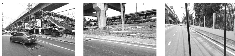
สภาพทางเดินเท้าบริเวณโดยรอบสถานี
