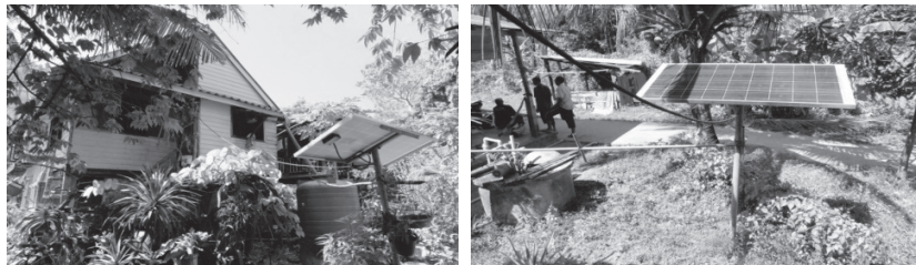
รูปที่ 6 แผงโซล่าเซลล์บนเสาเหล็กบนพื้นดินของบ้านพักอาศัยในชุมชนเกาะโหลน ที่มา: ผู้วิจัย (2560)
