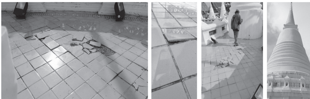
รูปที่ 2 ลักษณะของการหลุดลอกของกระเบื้องปูพื้นหลังคาระเบียงคดชั้นที่ 2 วัดประยุรวงศาวาสวรวิหาร ที่มา: ผู้วิจัย (2559)
