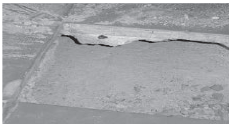
2.1.1 การหลุดล่อนเป็นแผ่นจากการปูที่ไม่ได้คุณภาพ
