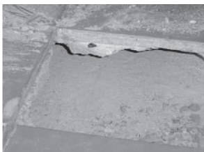
การหลุดล่อนเป็นแผ่นจากการปูที่ไม่ได้มาตรฐาน
