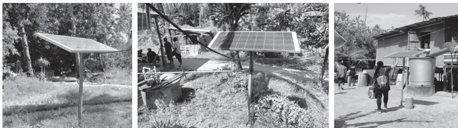
รูปที่ 4 โซลาร์เซลล์ Polycrystalline Silicon Solar Cells ที่มีการใช้งานในชุมชนเกาะโหล่น ที่มา: ผู้วิจัย (2560)
